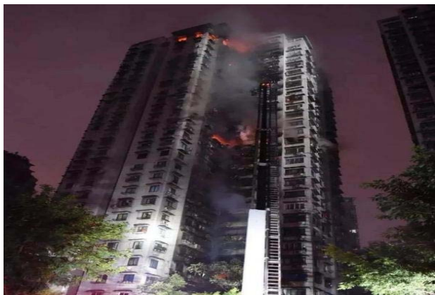
图1 高层建筑火灾现场图
