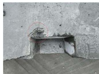
图2 装配式农房预留孔洞豁口图
