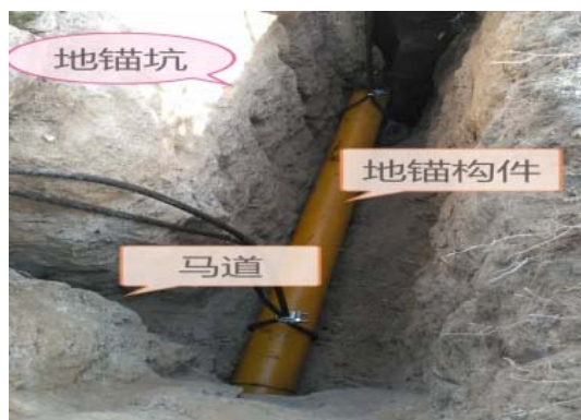
图8 地锚安装照片
