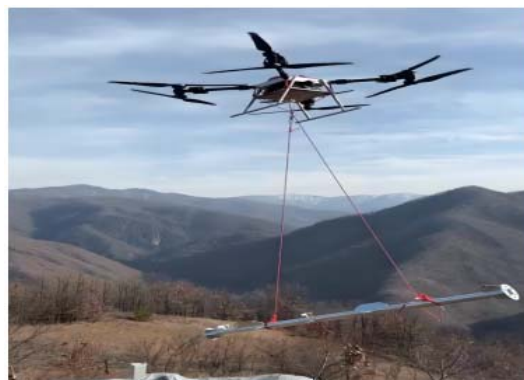
图9 支撑架无人机吊运
