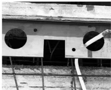
图2 定位钢板中的手孔位置
