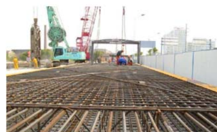
图1 施工焊接技术
