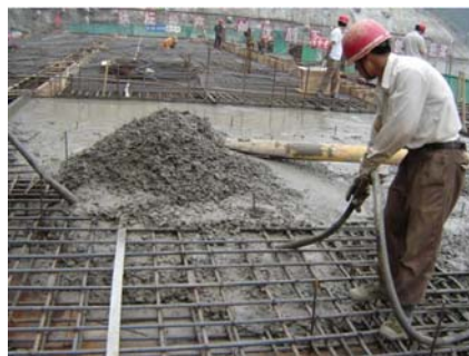
图2 混凝土浇筑
