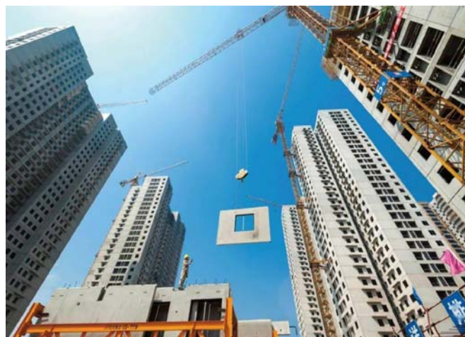
图一 装配式建筑施工技术在工地中的应用
