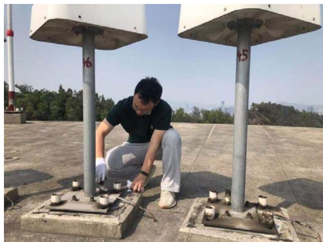
图1 台风前检查加固室外作业
