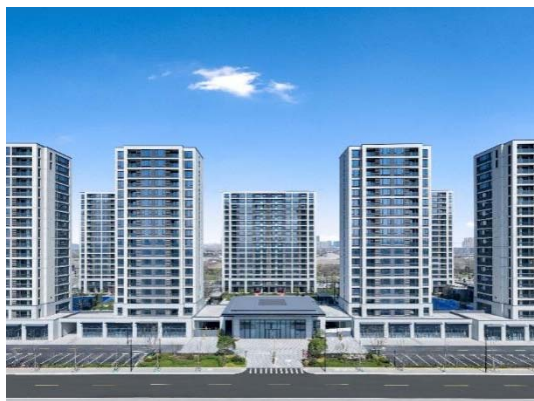
图1 安置房外立面(图片来源:作者自摄)
