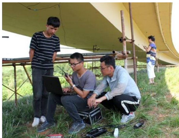
图1 加强路桥工程施工阶段的质量跟踪与动态调查
