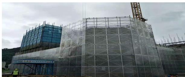
(5) 多利用。现有建设工程施工现场临边、洞口安全防护用具的种类繁多、制作材料、警示色和标识未做统一要求。铝合金安全防护网可同种产品分别作临边、洞口、材料堆场安全防护使用,统一安全防护用具的种类和规范使用。
